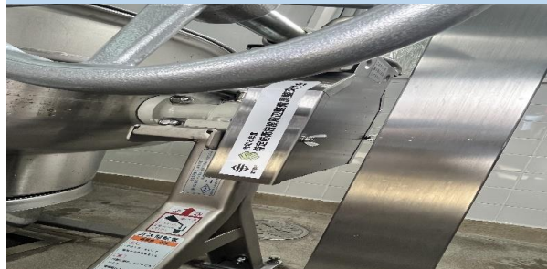
○ステッカーの貼付け
